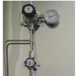
高潔淨度(BA)微洩漏的接頭及元件
